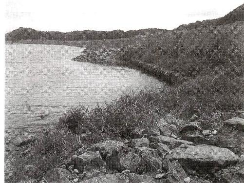
写真5: 下流域の坂本背割り堤における多自然型川作り施工場所の水制と低水護岸
