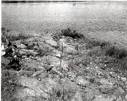
写真6: 巨石で構築された水制の上部から先端部
