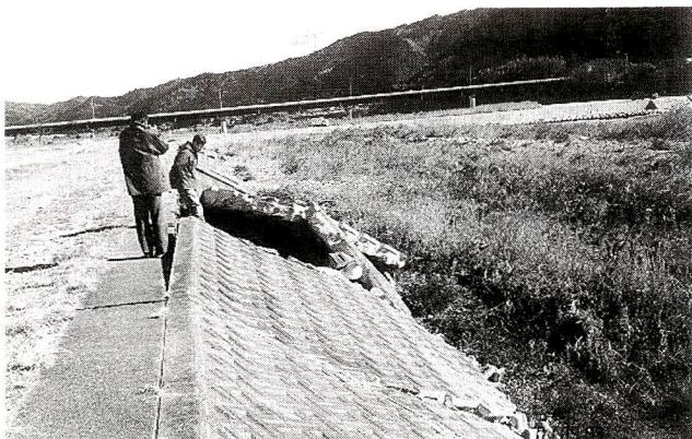
写真-5 野市統合堰下流右岸低水護岸の欠損
