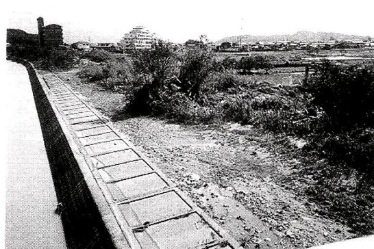
写真-9 国分川中流域の水越(越流)堤防
