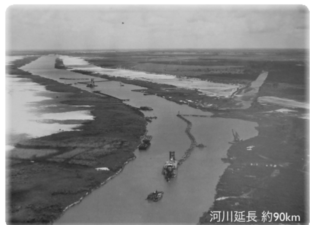
図2 かつて蛇行しながら流れていたキシミー川（左）と 浚渫により直線河道となったキシミー川（右） （River Woods Field Lab の壁にかかっていた写真を撮影）
