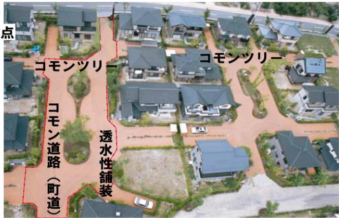
写真1 諏訪野団地全景と特徴的なコモンスペース
