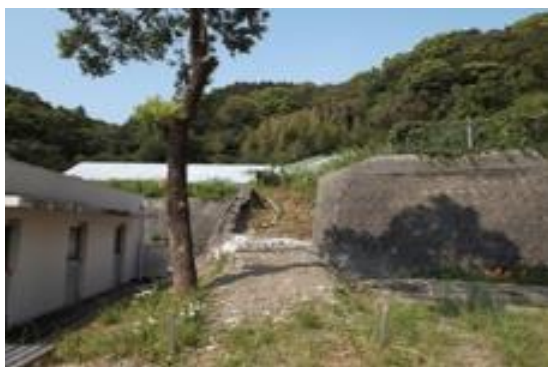
防災避難路の施工前
