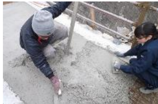
コンクリート打設・敷均し
