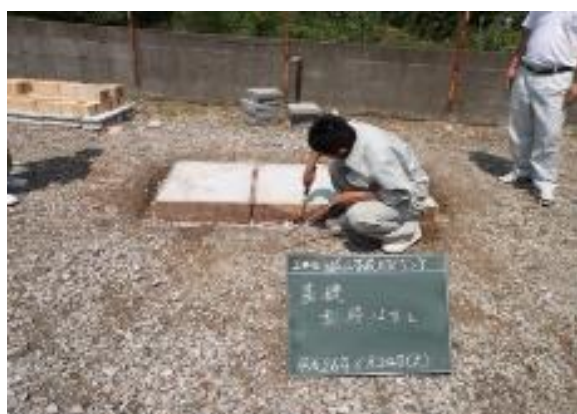
基礎型枠外し
