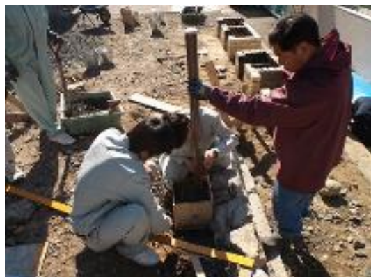
手すり基礎部製作
