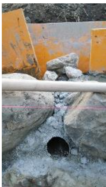
排水パイプ設置②
