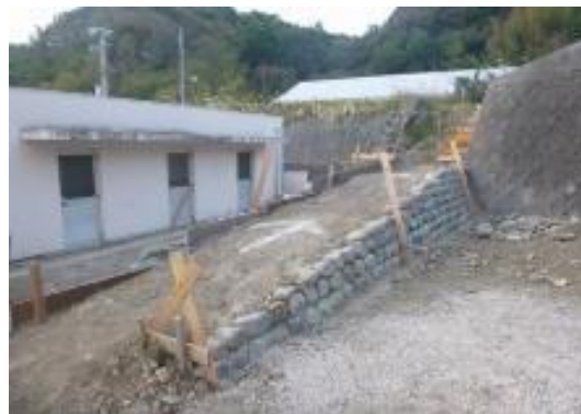
石積み（東側完成）
