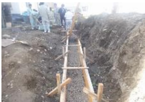
石積み基礎部
