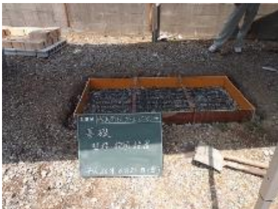
基礎型枠設置
