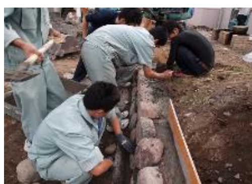
裏込め（コンクリート）
