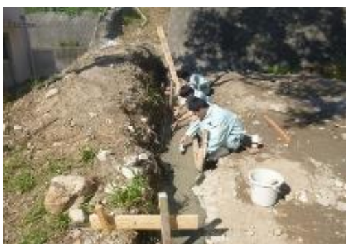
基礎コンクリート打込み
