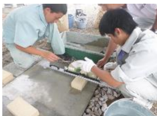
レンガ積み（水平を計る）
