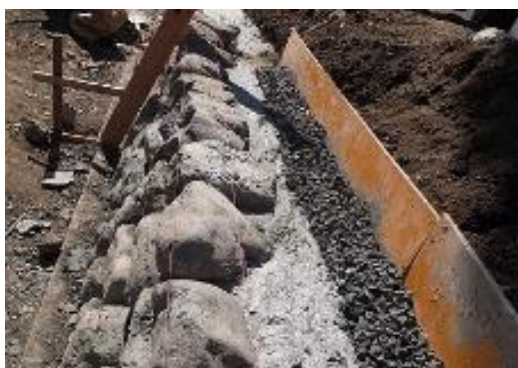
石積み（裏込め）
