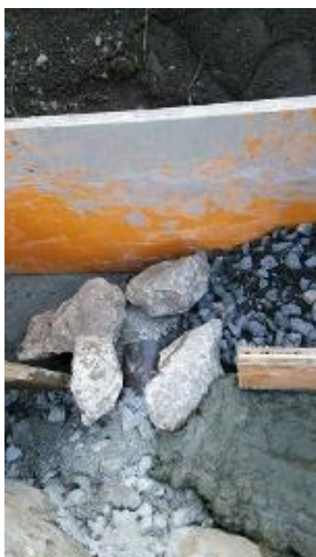
排水パイプ設置①
