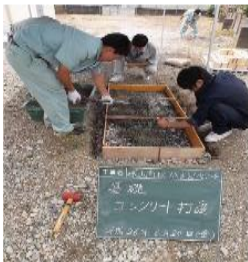
基礎コンクリート打設①
