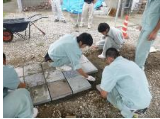
ブロック敷設②
