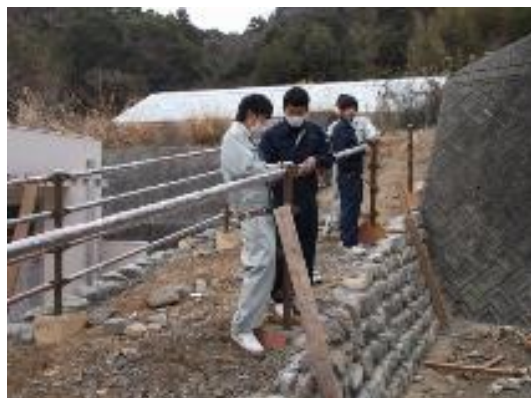
手すりパイプ取付
