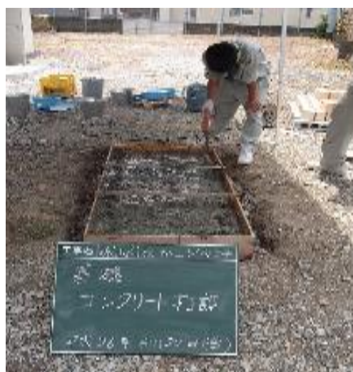
基礎コンクリート打設②
