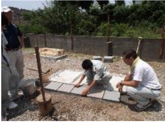
ブロック敷設①
