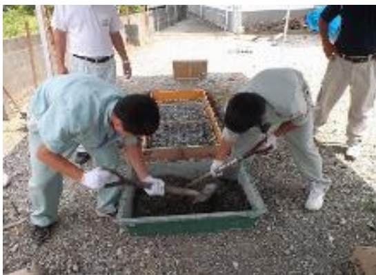
基礎部コンクリート練り混ぜ
