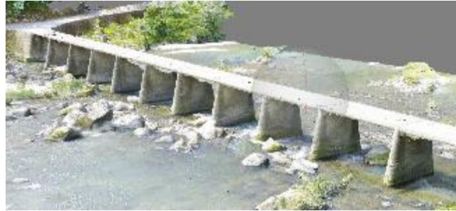
図-2 上宮沈下橋の 3D モデル
