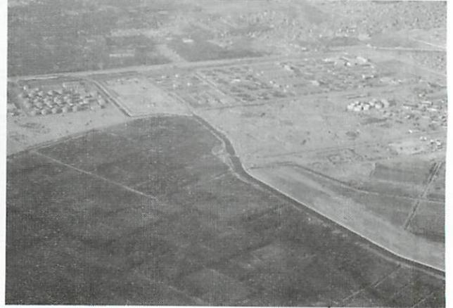
Fig. 13 ガーベルエルアスファ下水処理場(上方右側が流入、左端は一次 10 槽+二次 20 槽の汚泥消化槽群)。処理水と消化脱水汚泥によって緑化が進められている森林と緑地が手前に広がる。
