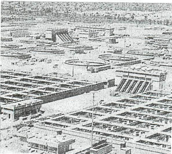
Fig. 12 ガーベルエルアスファ処理場のぼつき槽(スクリュエーポンプが段階毎にある。手前がぼつき槽、奥は最初沈殿池)。(photo: CWO)
